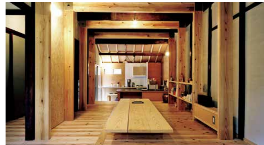
耐震リブフレームを挿入した豊崎長屋の内観。リブフレームで既存構造体を補強しつつ、フレームの間を棚として活用している [写真: John Barr]
