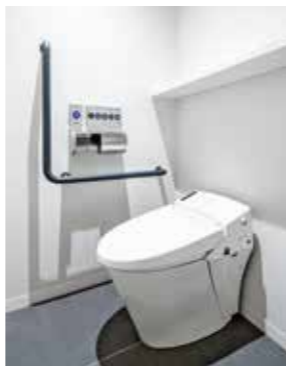
[写真4] 大便器個室内
