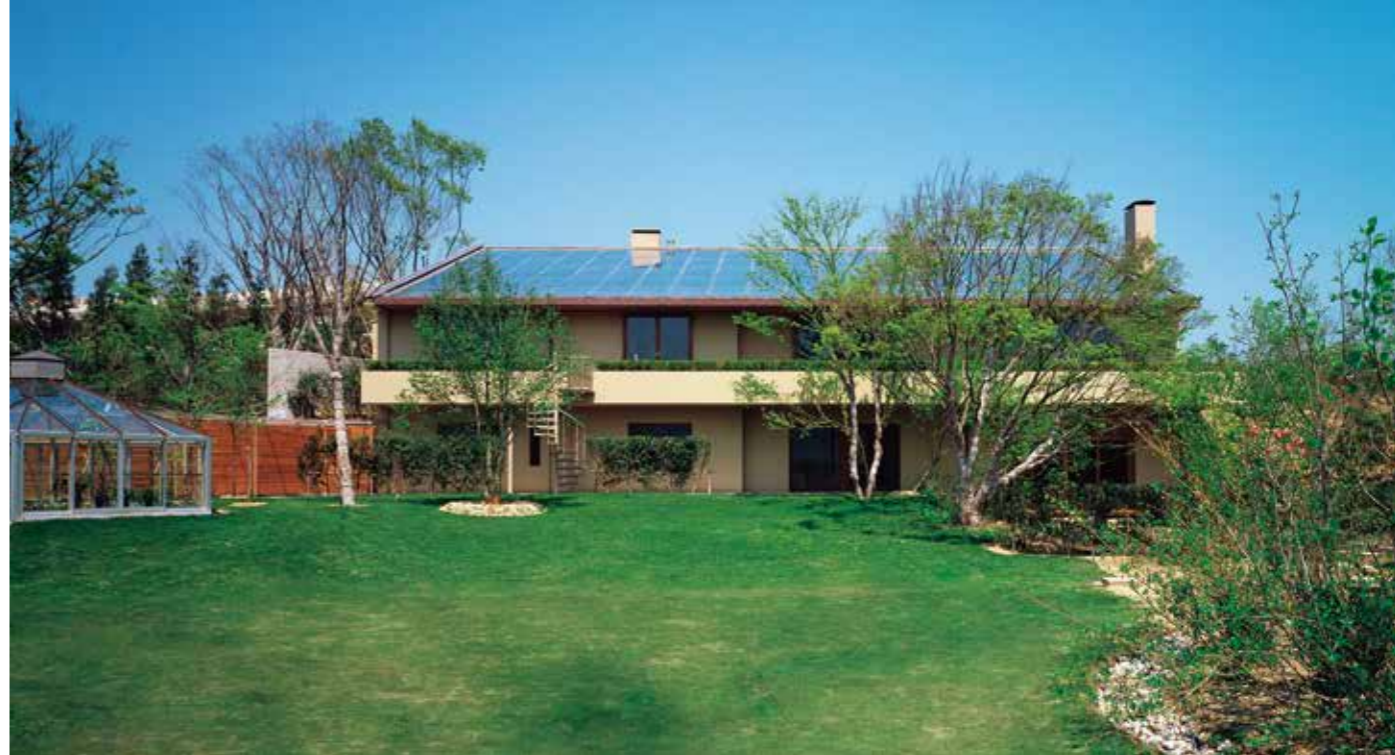
南側外観。片流れの屋根全体に100枚のソーラーパネルが載っている【写真：新建築社写真部】
