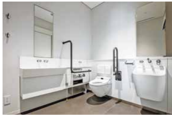
[写真5] 男女共用（多機能）トイレ内
