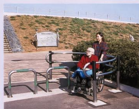
中央入口に設置された(ユニットレール1型 バイク進入防止ゲート)は利用者の安全を確保しています
