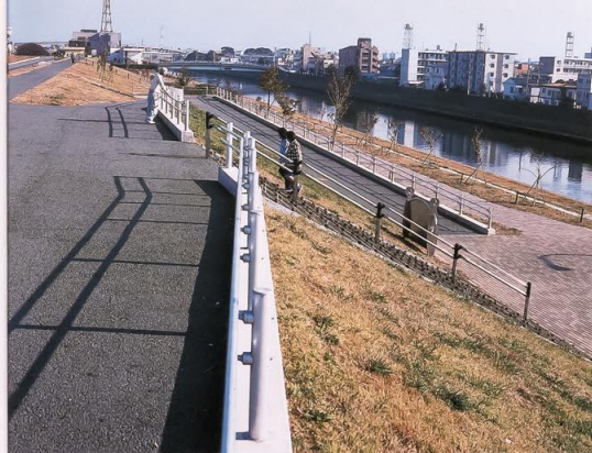
土手へのアプローチは階段とスロープ。どちらにも2段ビームの手すりが設置されています
