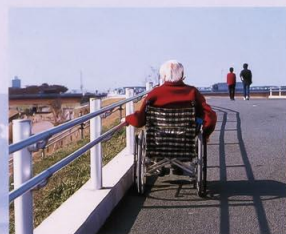
スロープに設置された(オリジナルアルミ手すり)は車いすの方でも利用できます
