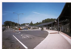
弓状に建てられた施設全景
