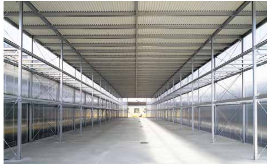
カモ井加工紙mt新倉庫@岡山県倉敷市
