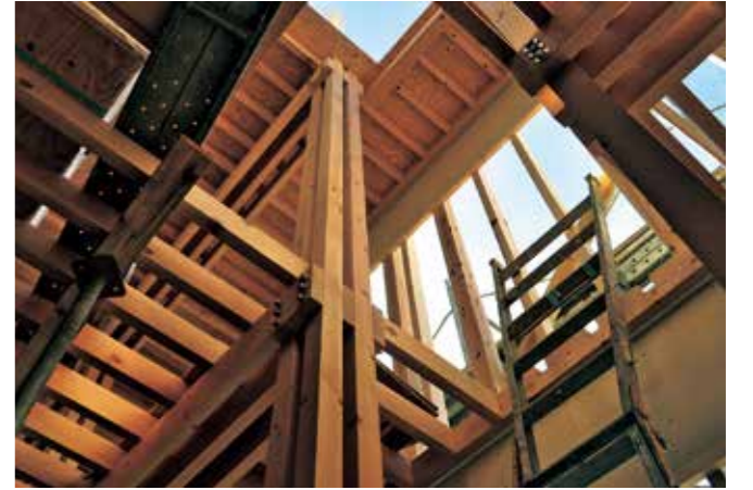
工事中写真。1階から上階まで4本の組柱につながる [写真：福島加津也＋富永祥子建築設計事務所]
