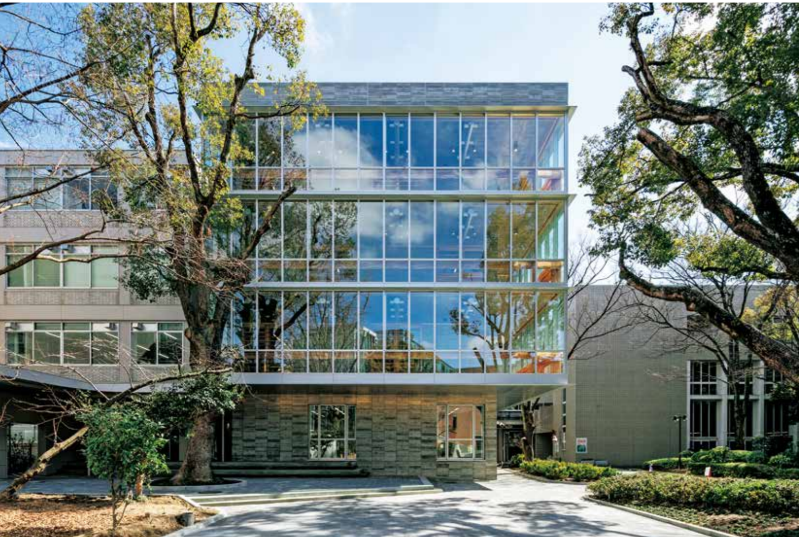
関西大学第4学舎1号館 / 耐震改修された既存棟 (左 / 村野・森建築事務所設計、1960年竣工) と、増築棟 (中央)。2棟をダンパーで連結することで制震を実現している [写真: エスエス大阪支店・土出得也]
