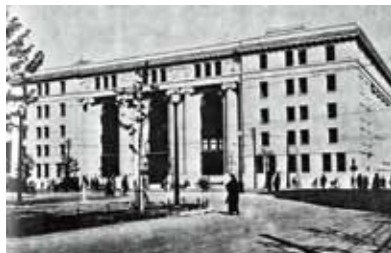
日本勧業銀行本店 (設計：渡邊節) [1929] 渡邊事務所の製図主任は早大時代に佐藤に学んだ村野藤吾であった。一方、施工を担当した清水組の技師長は、帝大時代の佐藤の同期で卒業後も極めて親交の深かった田辺淳吉であり、佐藤が日本勧業銀行本店の図面を事前に入手し、閲覧した可能性も考えられる [出典：「建築家 渡邊節」[社団法人大阪府建築士会 / 1969]]
