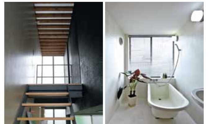
左一階から中2階に上がる階段。上部に見える梁の上はベッドコーナーの床の一部。この部分も吹き抜けにできれば「SETとSUBSET」のコンセプトはもっと明快になったかも！右一南からの光が燦々と差し込むこのバス・トイレ・洗面所は、素晴らしい気持ちの良いスペース。FRP防水にトップコートをかけて仕上げも、カッコイイ！
