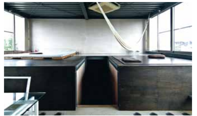
正面のふたつの黒いかたまりは、本文の中で「羊羹の空箱」にたとえた建物に貫入する筒。左側には納戸、右側にはバス・トイレ・洗面所がおさまられている。90センチ上がった部分にベッドマットが見える
