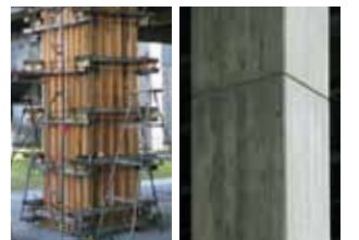
極薄コンクリート打ち増し工法上、左から一表面研り(30mm)、メッシュ取り付け、スギ板本実型枠建て込み、改修後 [提供4点とも: 竹中工務店]
