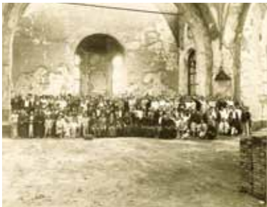
ニコライ堂改修直前の起工式での記念撮影 列最下段の中央には、岡田信一郎が座っている。表情は強張っており、その緊張がうかがい知れる写真である【所蔵：早稲田大学】
