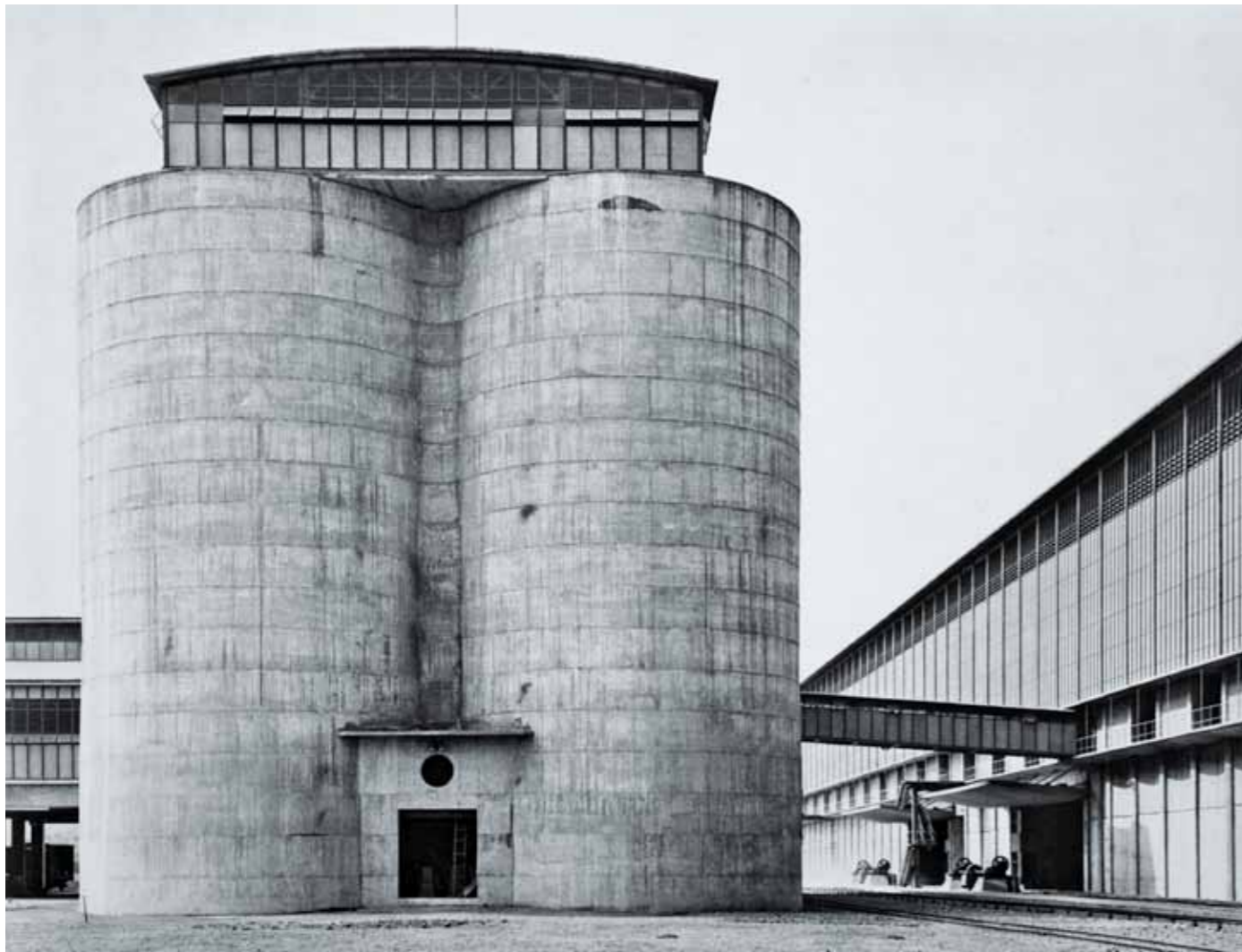
土建工事完了直後のセメントタンク【出典：「谷口吉郎作品集」】 鉄筋コンクリート造円筒型連結構造で、2列で後側に4基連なっており、計8基。外径13m、高さ28.5m、合計26,000tの容量がある。上部には17.25×41.45mの鉄骨造コンベヤー室があり、セメントはこの中を走るコンベヤーからタンクの中に落とし込まれ、貯蔵される。取り出しは、下を縦横に貫くトンネルのコンベヤーによって行われる。現役で使われており、小幅度の型枠による打放しコンクリート面は、今なお美しい
