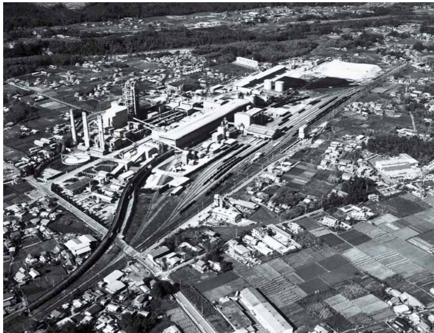
秩父セメント第二工場 航空写真：竣工後、約25年を経た1980年撮影：左側(西側)に乾式キルン(1号)、タワー、煙突を新設(1976年)。奥に石炭置場が見える[提供：秩父太平洋セメント]
