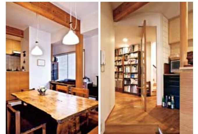
左—食卓の上に見える大梁は新たに差し替えたもの。この梁だけでなく構造材を何本も追加したり差し替えて耐震性を上げている。右—居間・食堂と廊下を仕切る大きな回転扉は軸吊りで、90度開くと扉の両側を通ることができる
