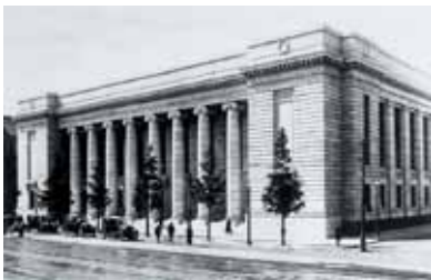
三菱銀行本店 [1922] 正面のイオニア式列柱と営業室の大空間が人々を圧倒したが、外観の構成は極めて単純・明快で、ニューヨークのナショナル・シティ・バンクを彷彿とさせる。鉄骨材は米国カーネギー社製で、構造は佐野利器が担当。設備機器や内外装材も欧米からの輸入品がふんだんに用いられている [出典：「明治大正建築写真聚覧」]
