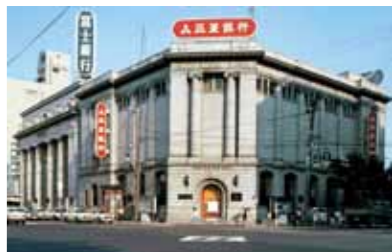
三菱銀行京都支店 [1925] 鳥丸四条の交差点に向かって入り口を開き、上部に2本のイオニア式円柱を掲げているが、側面はすべて付け柱とし、そっけないくらい平坦である。同様の構成は横浜正金銀行門司支店 [1934]でも採用されており、正面中央部の古典式列柱のみを強調する櫻井独特の銀行建築である [写真：筆者]
