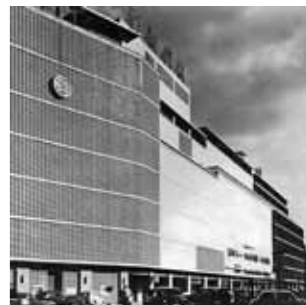
上ー難波高島屋本館とニューブロードフロアーを結ぶ階段[1950] [提供: 坂倉建築研究所] | 下ー南海会館[1957] [写真: 多比良敏雄]
