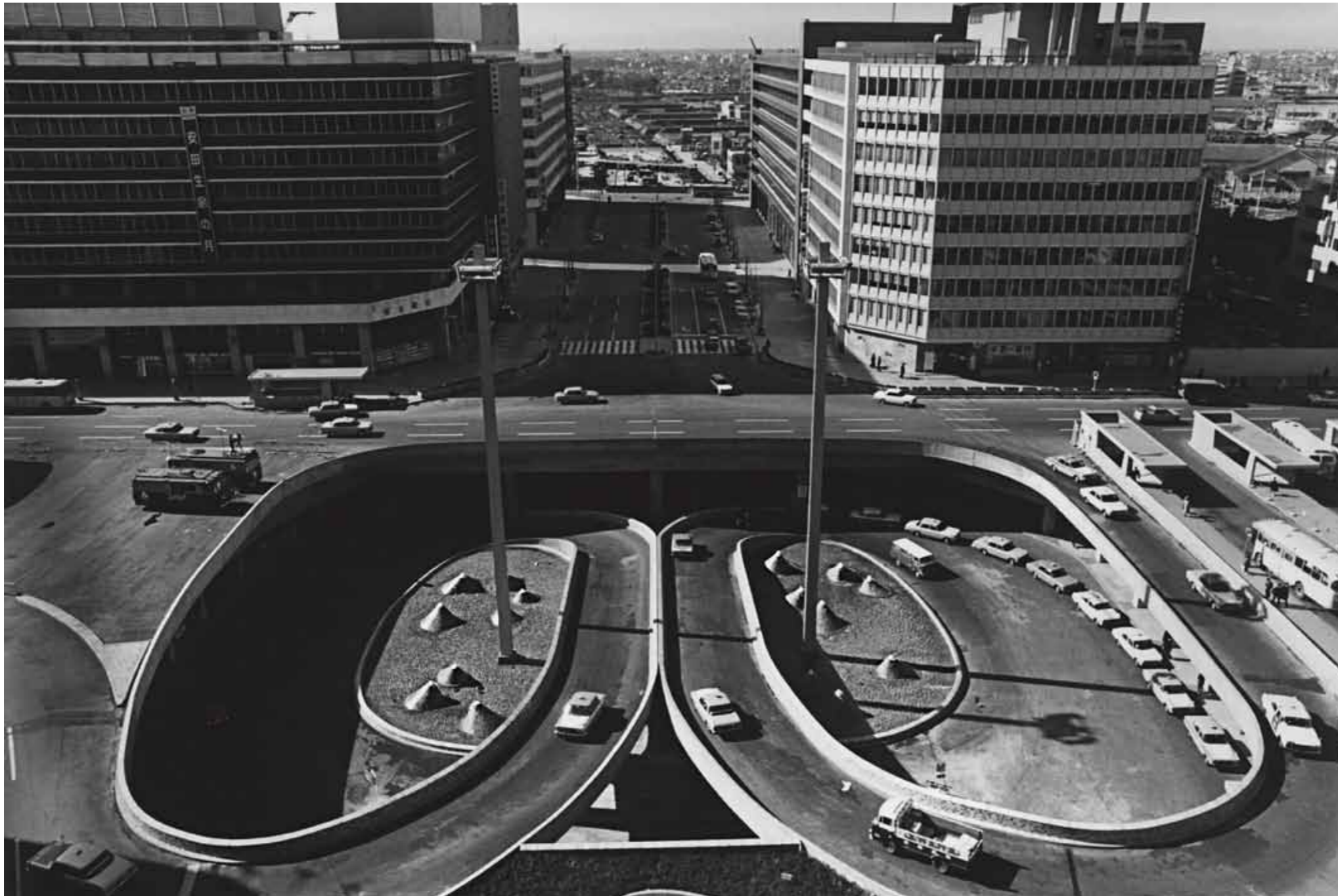
竣工時の小田急百貨店側から見た新宿西口広場中央開口部[写真：新建築社写真部] 当時はまだ副都心の超高層ビル群は建設されていなかった。昇降スロープは地下1階から、さらに下階駐車場に下る車路となっている。スロープに囲まれた広場中央は噴水を配した池であったが現在は緑地となっている。車路の機能がそのまま造形につながっていることが分かる。地上から見下ろしても地下から見上げて強い印象を残し、例え設計者の名前は知らずとも多くの市民が新宿のイメージとして記憶している空間である [解説：萬代恭博]
