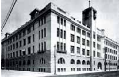
三菱仮本社 (22号館) [1918] 三菱本社の旧館で、完成直後に新館の増築工事 [1921] が開始されている。外壁を石張りおよび白色煉瓦張りとし、装飾を排除した簡素で軽快な建築であるが、左右非対称にこだわったのは櫻井の意図であろうか [出典：「丸の内百年のあゆみ 三菱地所社史 (上巻)」 [三菱地所社史編纂室編、三菱地所 / 1993]]
