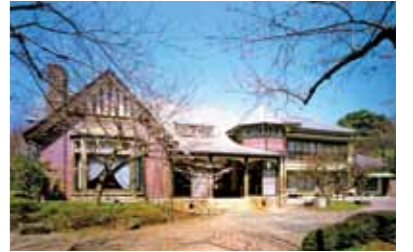
横須賀鎮守府司令長官官舎[1913] 中央に腰折れ屋根を架けて前面をチューダー様式のペランダとし、左右にハーフチンバーの妻壁と尖り屋根のベイウィンドーを配する。先行する呉鎮守府司令長官官舎に比べて一段と華やかであるが、非対称でビジュアルレスク風の構成を受け継いでいる【出典：『新横須賀市史別編 文化遺産』】
