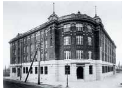
台湾銀行東京支店[1916] 櫻井が三菱に入社して最初に手掛けたSRC造の銀行建築。外壁1階は石張りの古典的な意匠であるが、2階以上は化粧煉瓦張りの壁面を縦長に配し、上部に装飾を集中させている。内部の営業室はゼツェシオン風の軽快な空間であった【出典：『明治大正建築写真集』【建築学会・明治建築資料に関する委員会編、日本建築学会/1936】】
