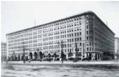
丸ノ内ビルディング [1923] 鉄骨幟壁造 8階建てのアメリカ式オフィスビル。外観は1階を人造石、2階以上をクリーム色の煉瓦タイル張りとした軽快な建築であったが、関東大震災 (1923年9月) 後の復旧工事で中空煉瓦造の幟壁がRC造に改修されたことから、外壁もモルタル吹付けに変更された [出典：「明治大正建築写真聚覧」]
