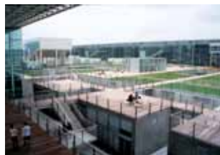
埼玉県立大学[写真:山本理顕設計工場]
