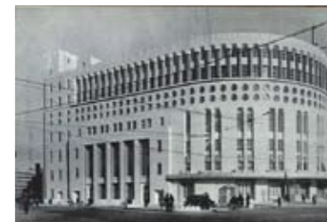
日本劇場 | かつては朝日新聞社本館と並んで建ち、数寄屋橋周辺の豊かな都市空間を形成していた。大きな円弧状の形態を用いることで巧みにまとめ上げられたモニュメンタルな外観。内部はアール・デコ調の華やかなインテリアで彩られていた[出典:『建築の東京』[都市美術協会/1935]]
