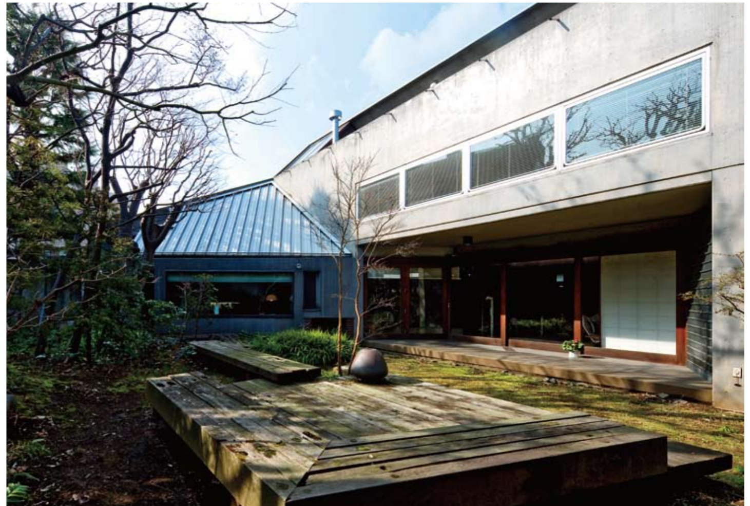
広々とした居間の大開口部。正面の横長窓はカウチのある「洋風茶の間」。上部の三角屋根の屋根裏にサウナと水浴室が最小限寸法で収まっている
