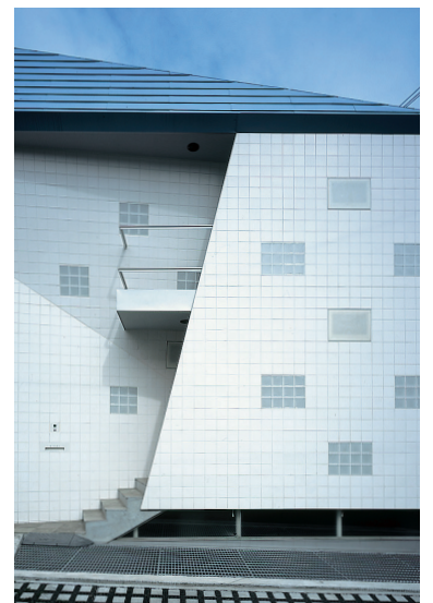
左—東面全景 内部の明かりが外部に漏れる夕景 右—南面外観 正面の階段を上ると玄関。ガラスブロックとタイルサイズを合わせ、目地を通して
