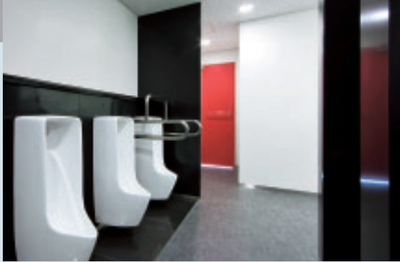
27階男子トイレ ●INAX使用商品●小便器：U-406RCD、赤外線センサー：A-3673、手すり：KF-701S
