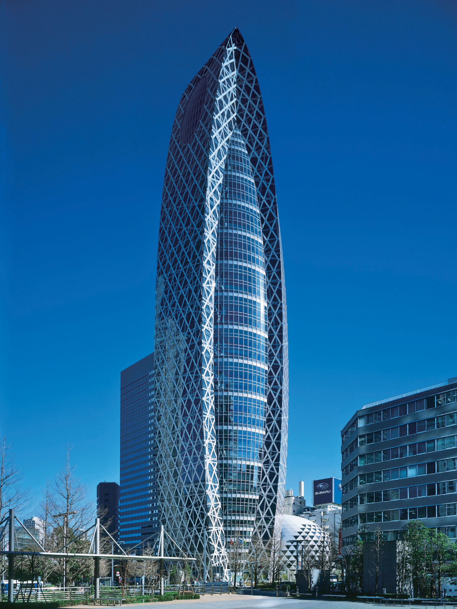
南面全景 最高高さは203.65m。特徴的な蕨模様は、ダイアゴナルフレームの斜め格子柱に合わせたアルミ押出パネルと、三角形のガラス面に貼られた特殊フィルムによって構成されている。右側の卵型の低層部には、一般にも開放している2つのホールが入る
