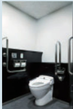
27階多目的トイレ ●INAX使用商品●洋風便器：C-24PRCN、タッチスイッチ：OKC-2B-TU2、シャワートイレ：CW-P22F-TUC、紙巻器：CF-62HS、手すり：KF-920SR50、KF-480SH70
