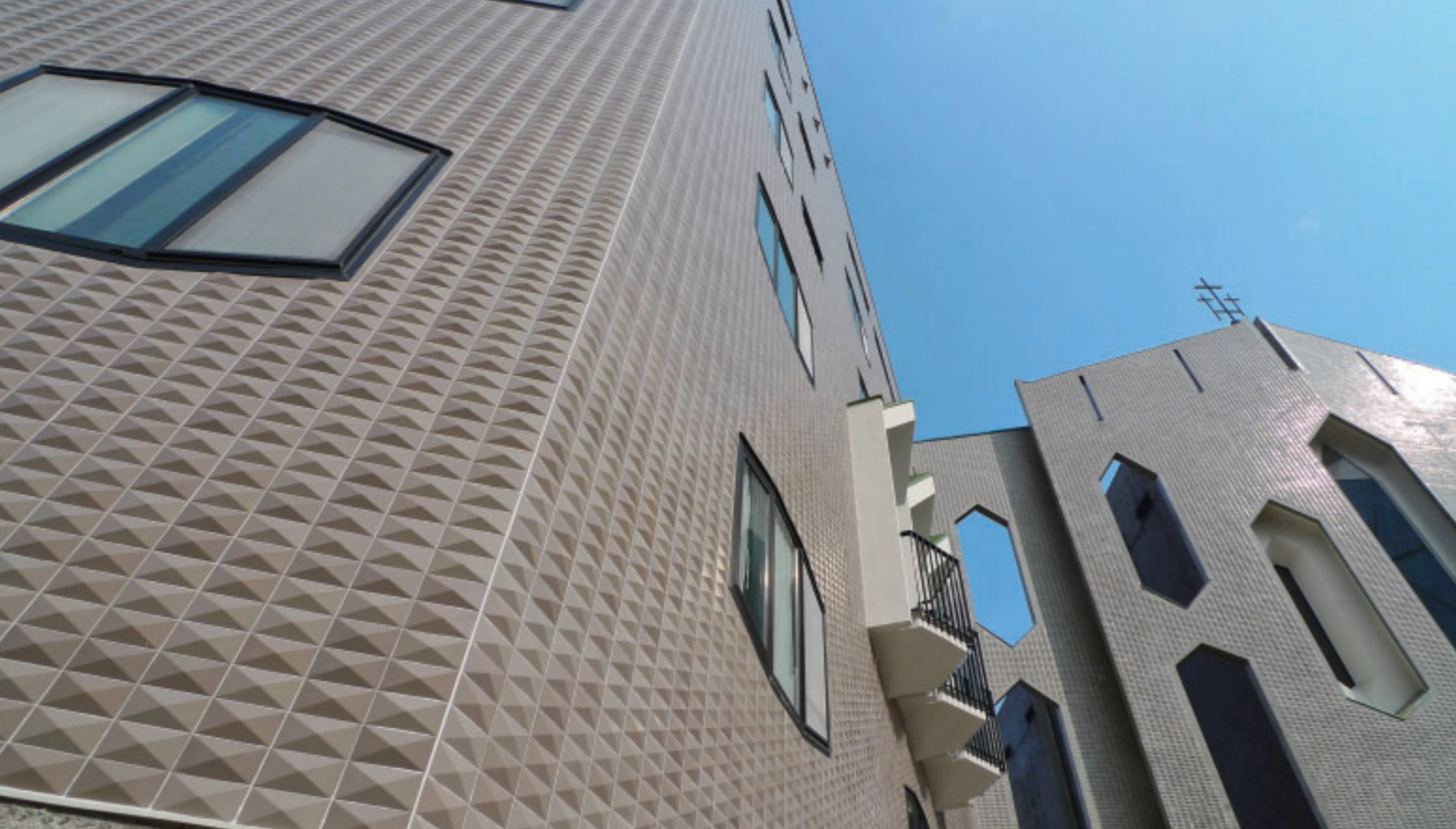
左翼棟のディテール 四角錐型のタイルが見る角度によってさまざまに表情を変える☆
