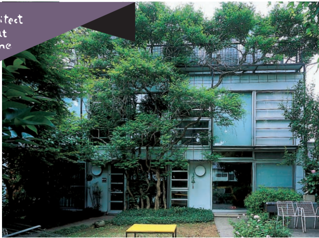
庭に入るとようやく建物の南立面が見える。建物の真ん中に日射調節の目的で植えられたノウゼンカズラが伸びに伸びて屋上にまで達している
