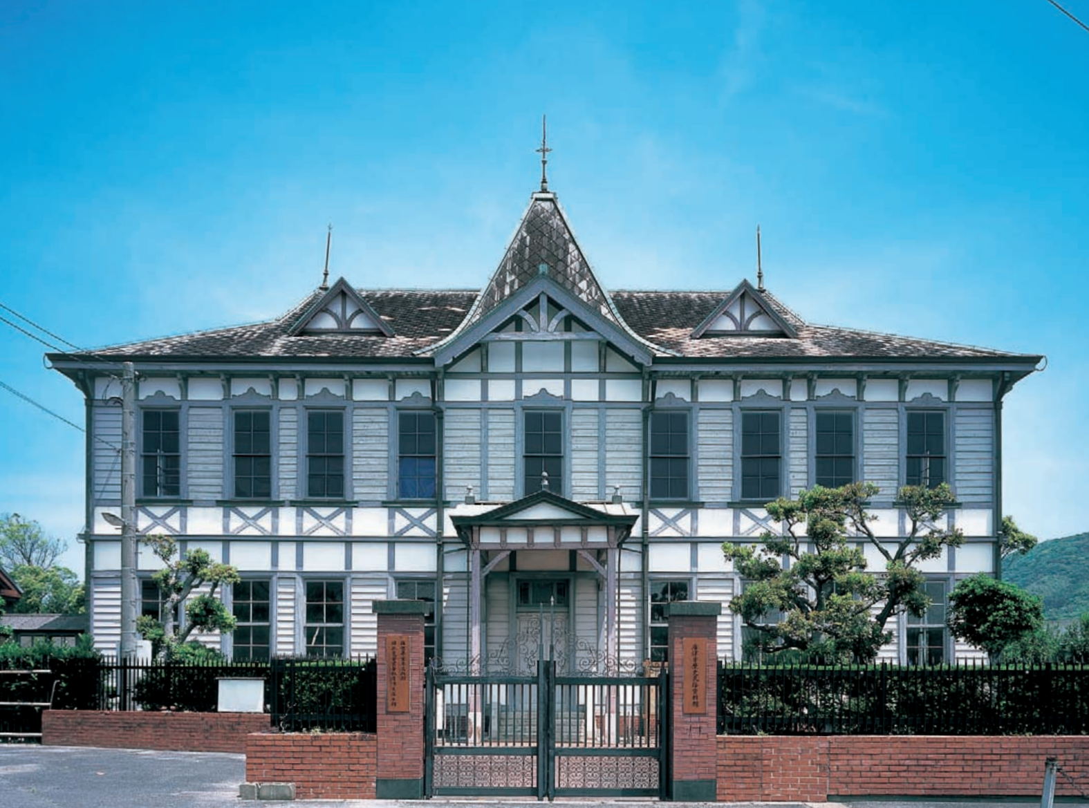
北面全景 外壁や破風に柱や長押状の線材がくっきりとその姿を見せる、いわゆるハーフティンバー様式を基調としたデザイン。大隈邸でもハーフティンバー様式を採用しており、保岡の好んだスタイルであったことをうかがわせる。また、屋根が独創的で、中央に配された急勾配の塔屋根や、リズムカルに配された縦長窓の外観は、初期の丸の内のおフィスビルを彷彿とさせる。一方、全体は伝統的な入母屋造りの大屋根のため、遠くから眺めると和風の御殿建築のようにも見えるなど、不思議な印象を受ける
