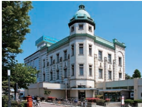
第八十五銀行本店（1918）事務所開設時は、金融関連の作品を多く手掛けていた。その時代の様子を示す作品。ルネサンス様式を基調としながらも、ゼブラ模様の付け柱やアーチ、開口部の窓台のデザインなど、サラセン風のモチーフが見られる。保岡の作品の中では、外観の装飾性が豊かな建築であるが、そのデザインは幾何学的な形に単純化されたもので、モダンさがうかがえる。現在、埼玉りそな銀行川越支店として使用されている。登録文化財
