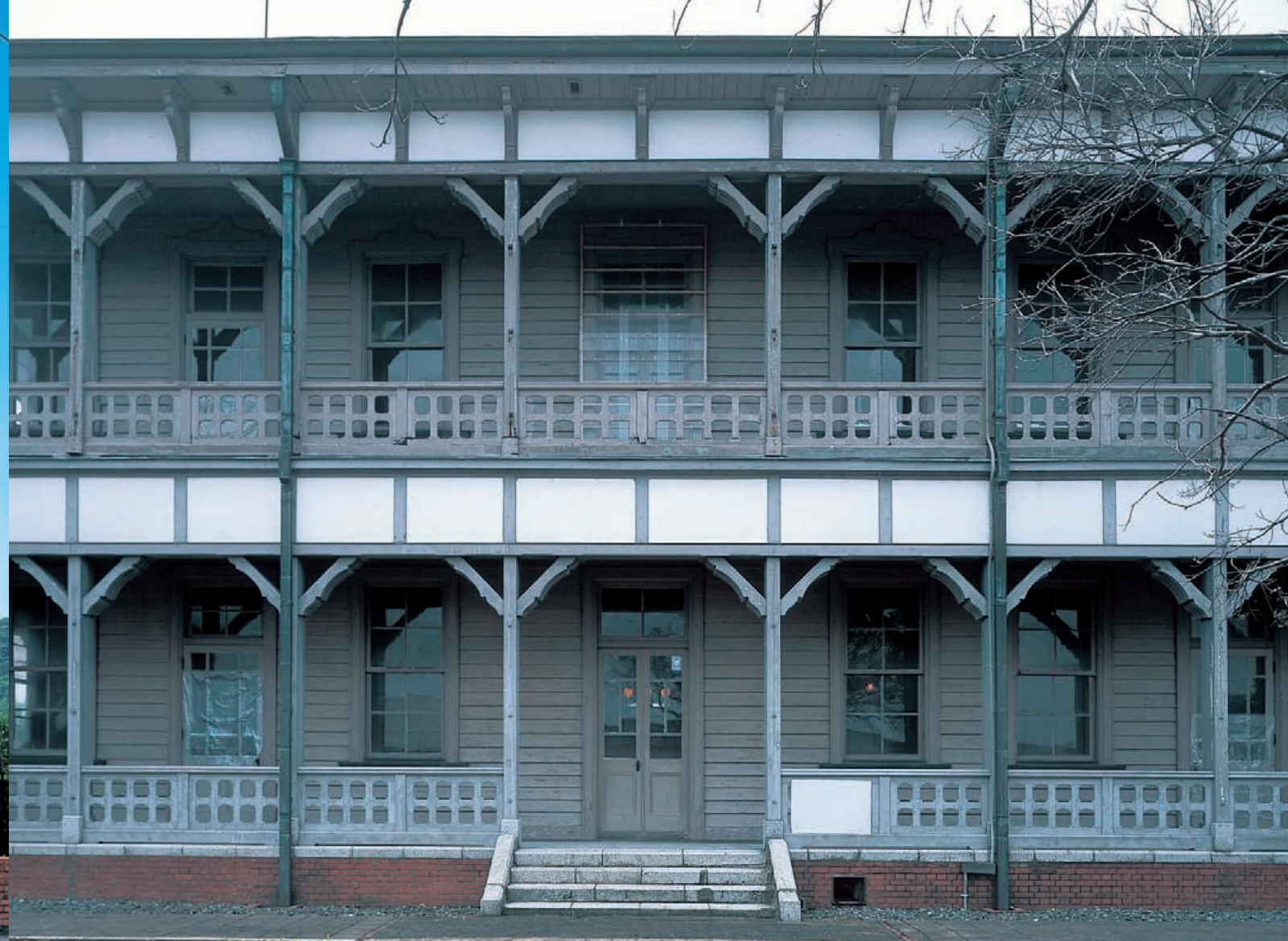
南面外観 南側は海に面しており、その広大な眺望を楽しめるように1・2階に開放的なベランダが配されている。柱の両脇のブラケットには、わずかながらも曲線状の加工が施されており、硬直感を和らげている
