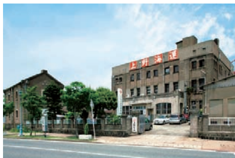
三菱合資会社若松支店外観 玄関と看板を掲げている最上階はともに増築。外観は極めて質素で、装飾らしきものがないものの、注意深く見ると開口部周囲にはレンガ造を補強する石が配されており、装飾の代わりに担っていることが分かる。こうした外観のデザインも、モダンな吹抜け空間同様にセセッション風といえる。なお、本館の脇のレンガ倉庫も創建時のものという。大正初期の雰囲気を残す貴重な遺構である
