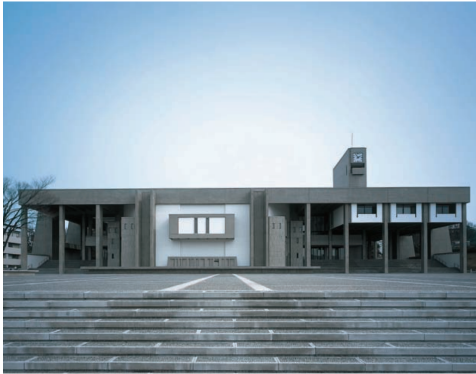
上—正面全景 下—北側のピロティから後方を見る 右—図書館から講堂を見る
