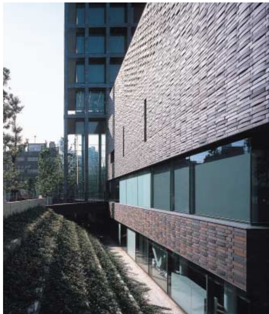
昇庭に面した低層部のレンガ積み外壁
