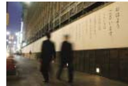
メッセージのあった仮囲い（2006）
