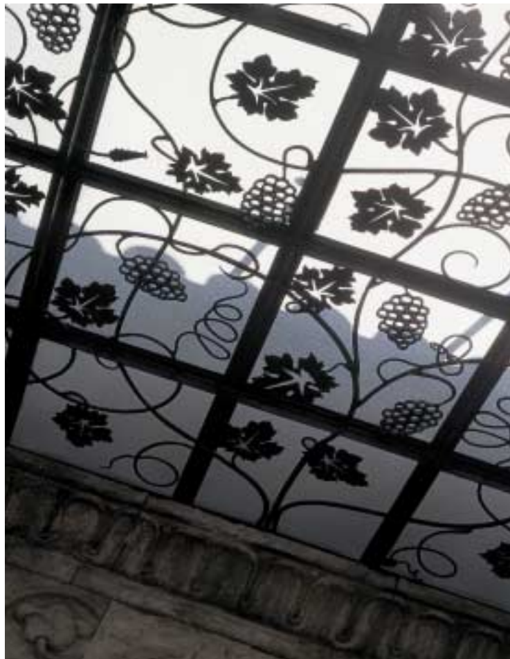
正面玄関上部の庇 鉄製の装飾が美しく、葡萄棚から日が差すようにデザインされている。修復の際に安全性などから材質が変更されたが、当初はガラスはめられ、青空も透かして見えた
