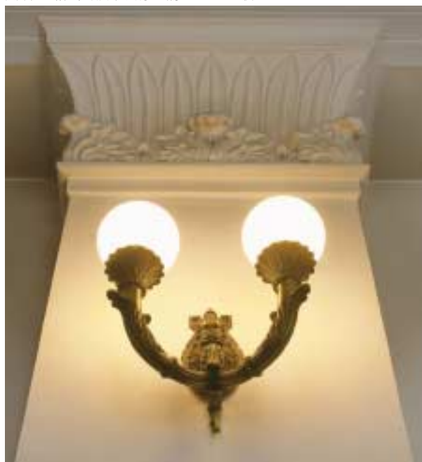
旧営業室2階の柱頭装飾 照明も当初からのものが使われている
